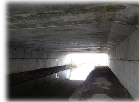
Ouvrage hydraulique de l'autoroute A19 et Petit Fusain favorable aux chiroptères
